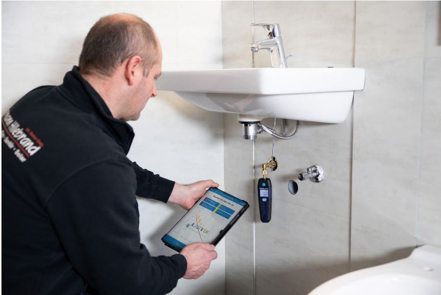
Bild: Druckprüfung Wasser
