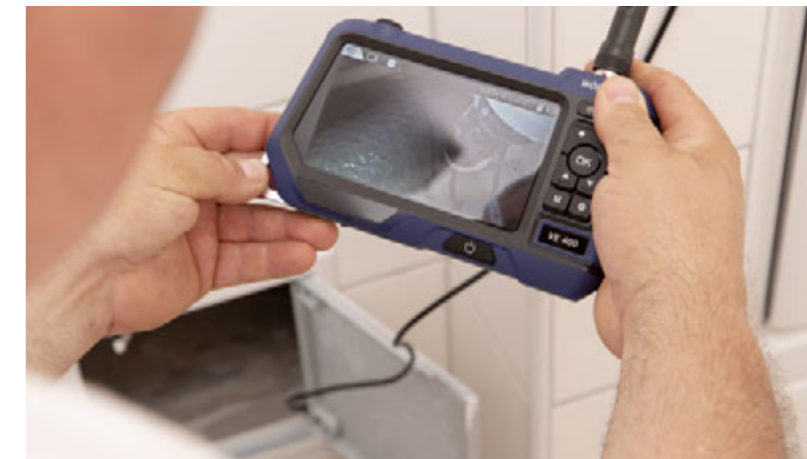
Feuchtigkeit unter der Badewanne? Mit dem Wöhler VE 400 ist die Ursache ganz schnell gefunden, ohne dass „große Geschütze“ aufgeföhren werden müssen.
