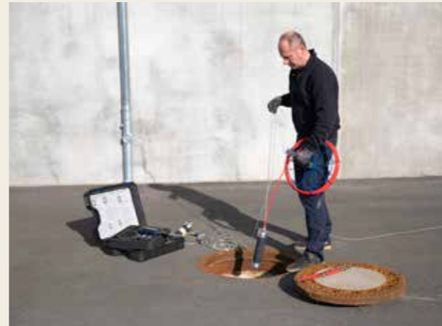
Vor der Dichtheitsprüfung an Abwasserleitungen nach DIN EN 1610 werden die Prüfabschnitte mit Blasen abgedichtet.
