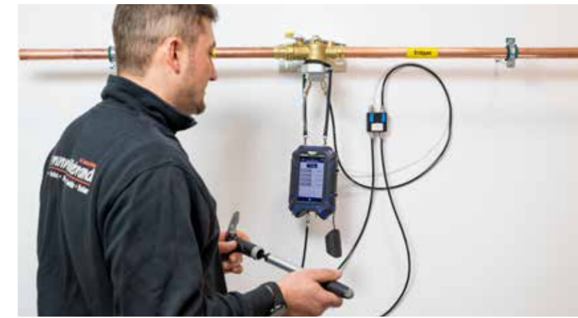
Mit dem passenden Anschluss-Zubehör wird die neu installierte Gasleitung ganz einfach mit dem Prüfdruck für die Belastungsprüfung (1000 hPa) beaufschlagt.
