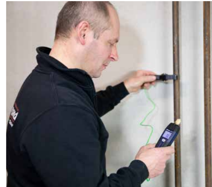
Mit der Temperaturmesszange lässt sich die Rohrtemperatur bestimmen.
