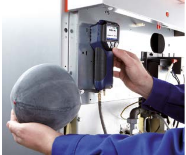
Prüfung mit Betriebsgas bei Betriebsdruck durch Verwendung der Gasblase.
