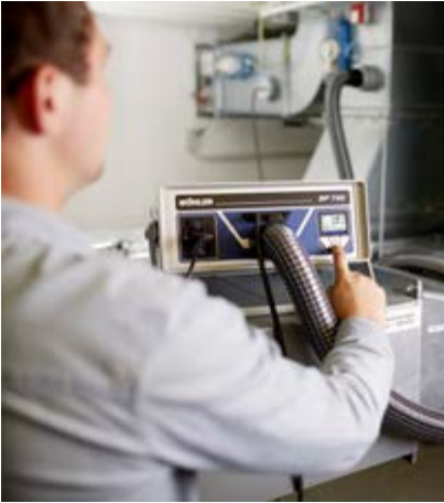
Dichtheitsprüfung an installierten Luftleitungssystemen mit mehreren 100 m 2 .
