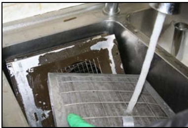
Fig. 20: Rinçage des pièces nettoyées
