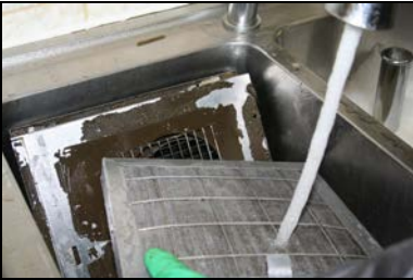
Abb. 9: Abspülen der gereinigten Teile
