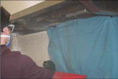
Abb. 4: Abdecken des Arbeitsbereichs
