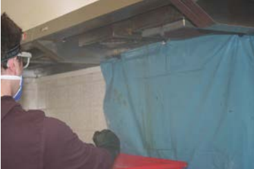
Abb. 3: Abdecken des Arbeitsbereichs
