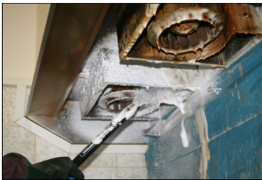
Abb. 5: Auftragen des Reinigungsschaums
