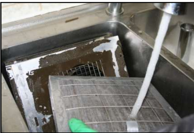
Abb. 7: Abspülen der gereinigten Teile
