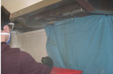
Abb. 3: Abdecken des Arbeitsbereichs
