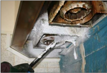
Abb. 5: Auftragen des Reinigungsschaums
