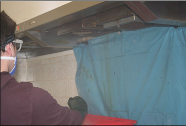
Abb. 4: Abdecken des Arbeitsbereichs
