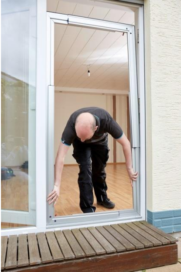
Abb. 7: Rahmen in den Türausschnitt einpassen
