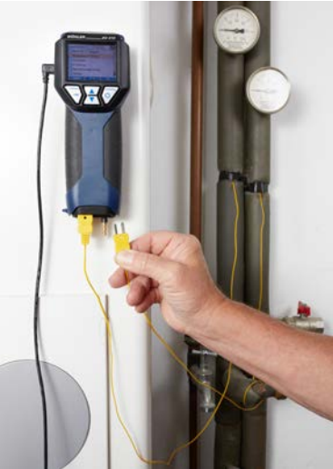
Abb. 19: Befestigen der Temperatursensoren an Vor- und Rücklauf
