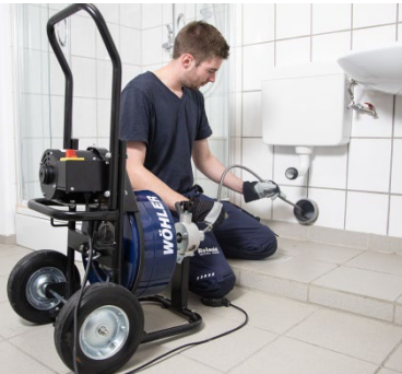
Afb. 18: Pijpreiniging
