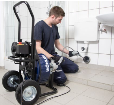
Abb. 8: Rohrreinigung
