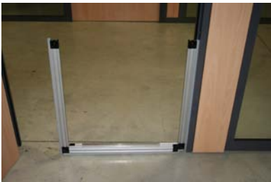
Abb. 3: Aufsetzen der seitlichen Elemente
