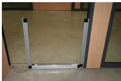
Fig. 19: Montage des éléments en position latérale
