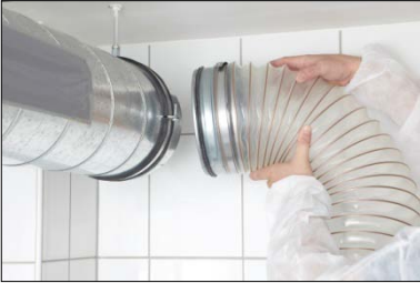
Fig. 21: Collegamento del tubo spiralato all'impianto da pulire
