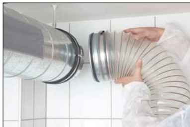
Image 9: Connecter le tuyau au tube à nettoyer
