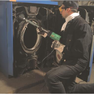
Abb. 6: Reinigung des Kesselinnenraums
